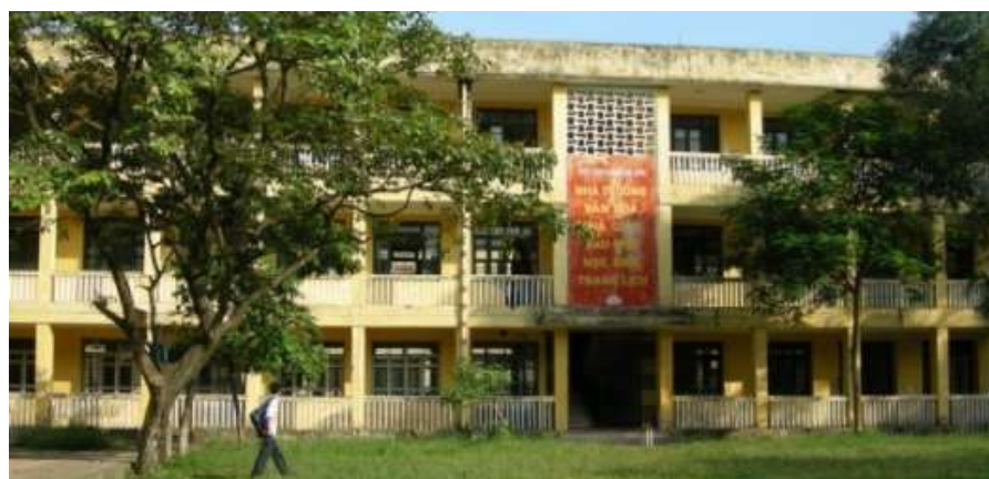
Blick auf das renovierungsbedürftige Schulgebäude
